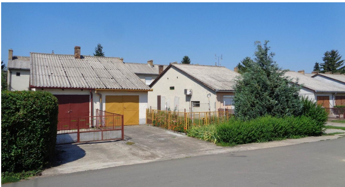
A Kanizsai Dorottya lakótelep mellépületei előtt szabadon hagyott bejárók és előkertek
