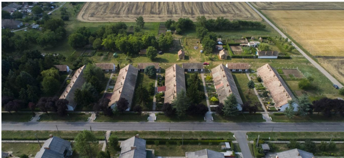
Az 1800-as évek végén épített cselédházak sora a magasból
