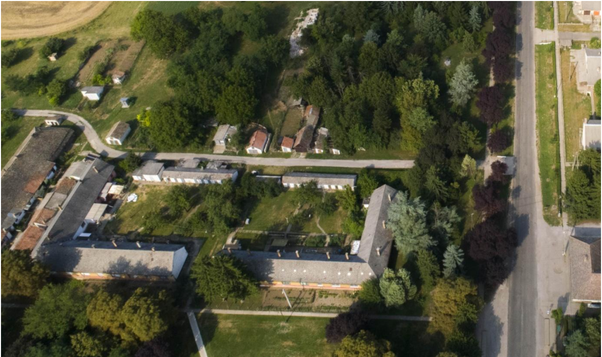
Ma többablakos épületként használt átalakított uradalmi kiszolgáló épületek
